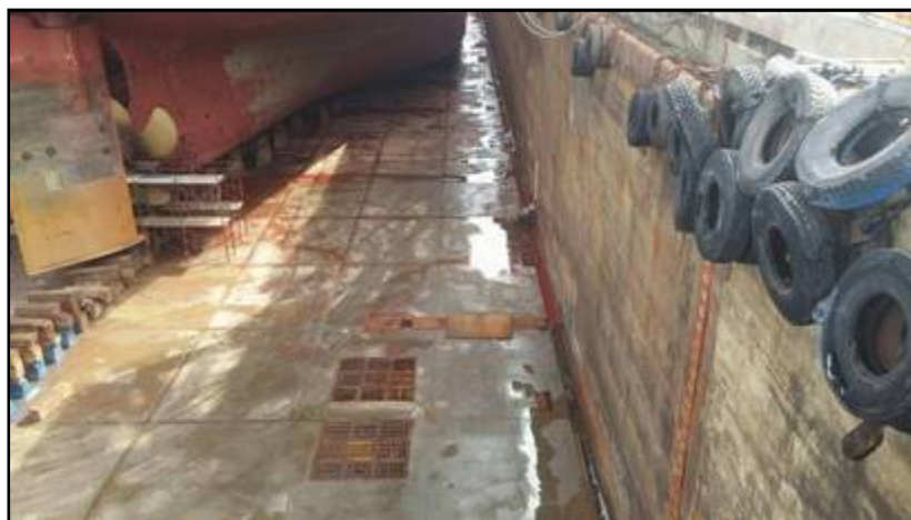
Canali di raccolta
