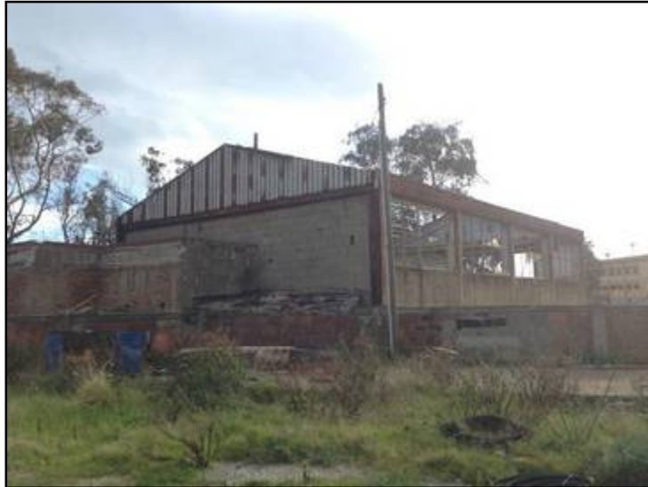
Manufatto da demolire
