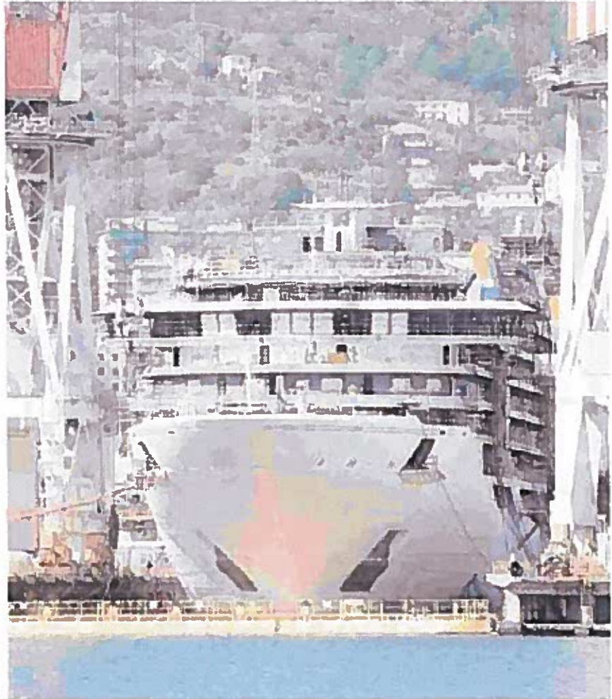
Lo stabilimento Fincantieri di Sestri Ponente visto dal mare
