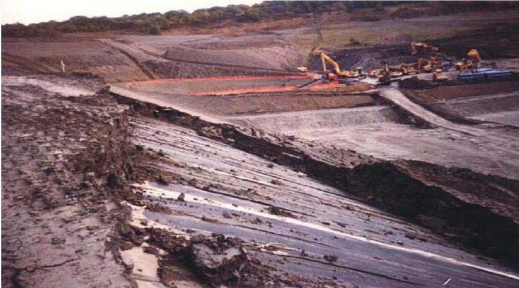
Scivolamento lungo un'interfaccia interna ad un **geocomposito drenante**, durante le fasi realizzative di una barriera laterale (USA, 1996)
