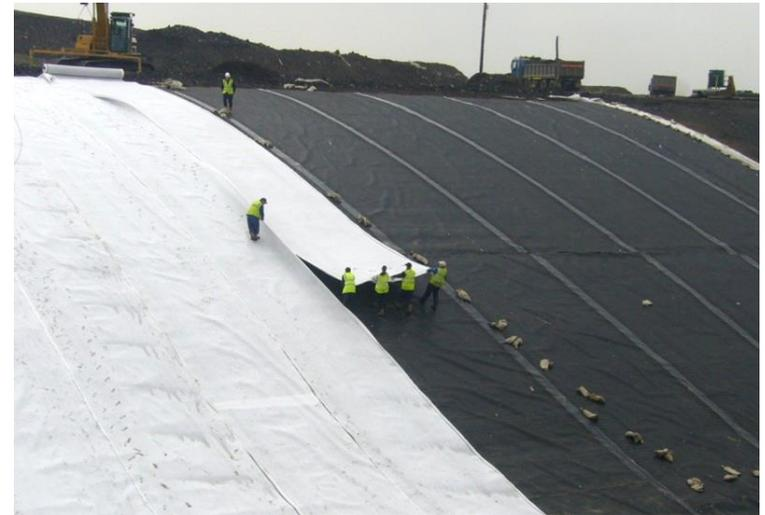
Il loro impiego comporta la creazione di interfacce tra polimeri e tra polimero e terreno, che possono mobilitare i seguenti meccanismi resistenti:
