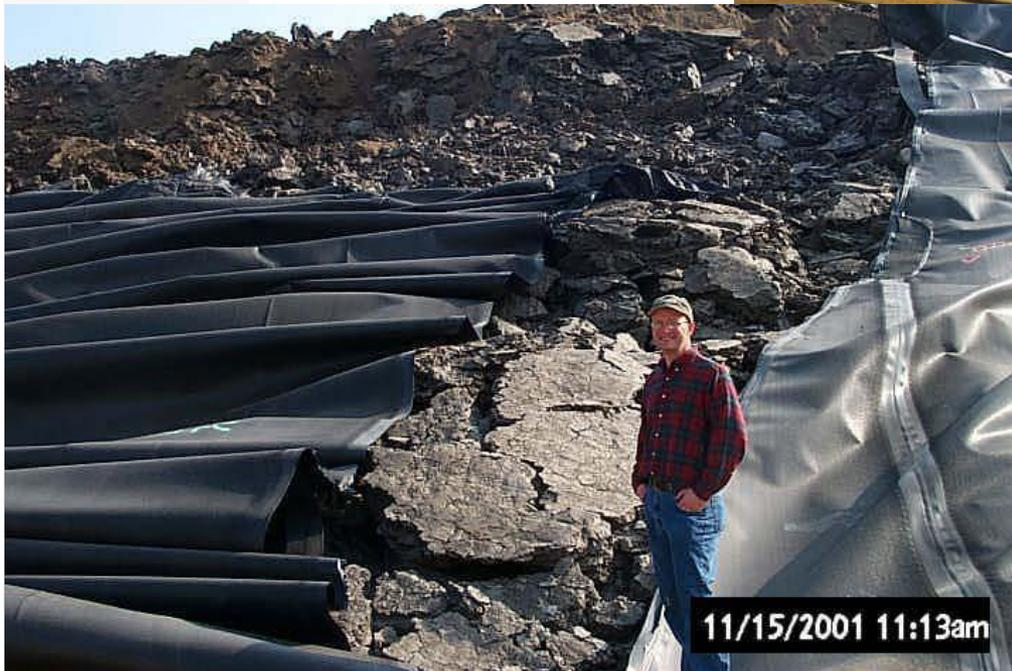
Scivolamento del **terreno** e rottura della **geomembrana**, durante le fasi realizzative di una barriera laterale (Ohio, USA, 2001)
