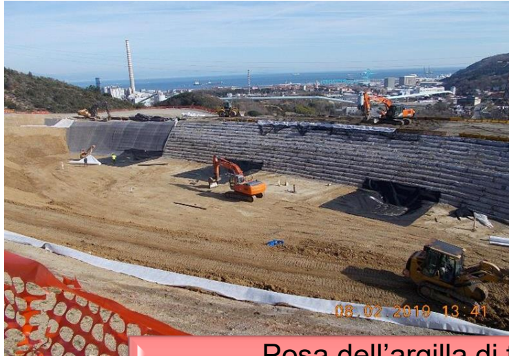
Posa dell'argilla di fondo e dei geosintetici
