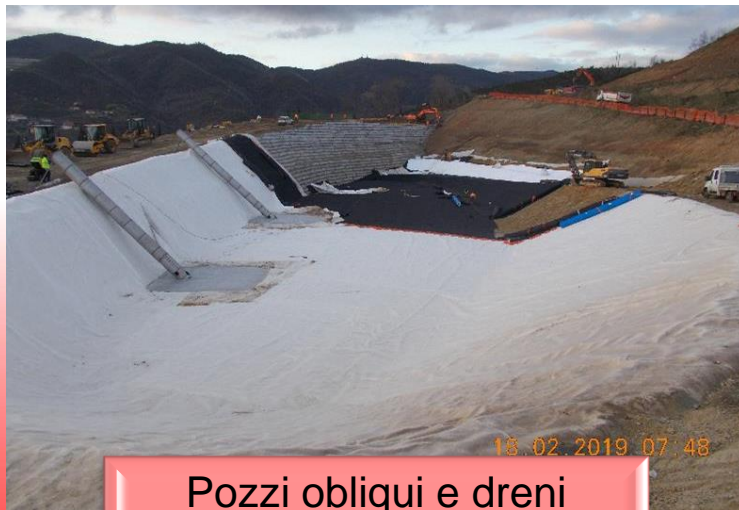
Posa dell'argilla di fondo e dei geosintetici
