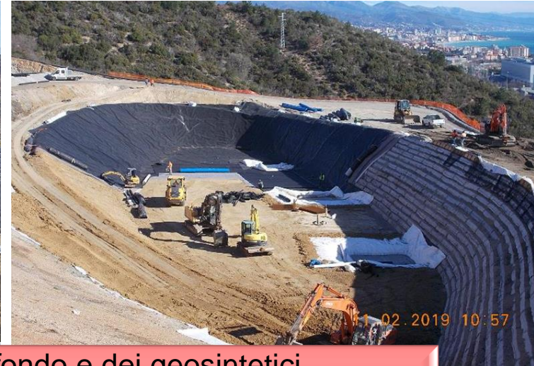
Posa dell'argilla di fondo e dei geosintetici
