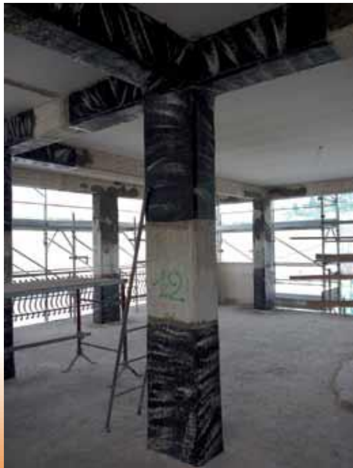
Rinforzo nodo trave-pilastro L'Aquila
