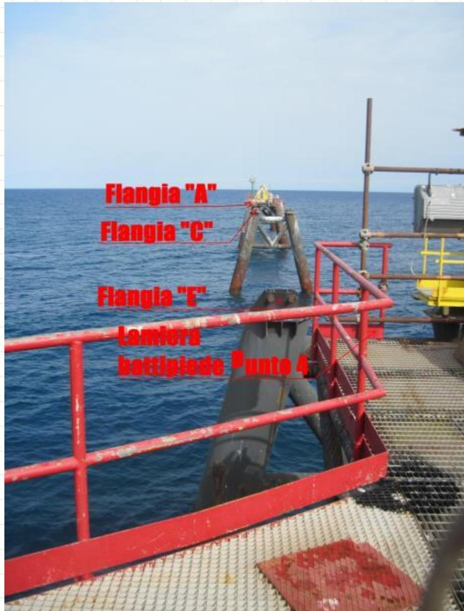
Per il rilievo è stata utilizzata una stazione totale robotizzata «Leica TS30» con precisione angolare di mezzo secondo centesimale, dotata di misuratore laser. Il rilievo è stato effettuato da due stazioni delle quali la «100» in linea con le flange ovest dei piloni e la «200» posta su braccio laterale del pontile principale. Con un siffatto schema di rilievo si è avuta la possibilità di iperdeterminare la posizione delle flange.
