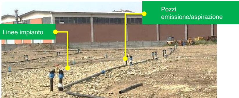
Particolare: pozzi e linee impianto
