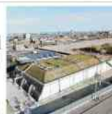
Una vista aerea dell'impianto gpl di Chioggia.
