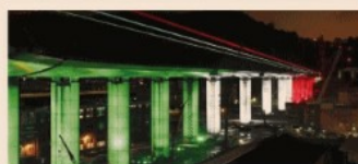
Finito. Posata l'ultima campata del nuovo ponte di Genova sul Polcevera
