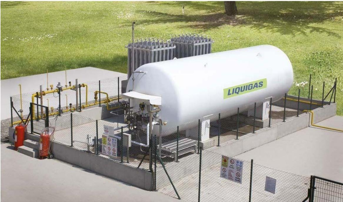
Figura 43 - Esempio di Serbatoio Criogenico ad asse orizzontale (fonte: [www.teknoring.com](http://www.teknoring.com))
