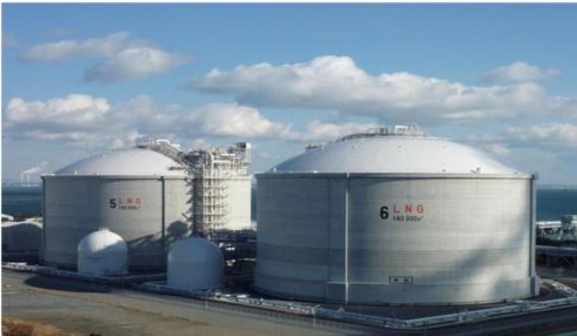
Figura 44 - Esempio di un Serbatoio criogenico ad asse verticale
