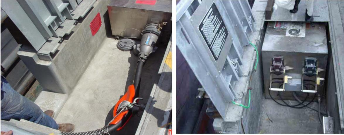
Figura 23 - Shore-Box per un cavo di connessione (Sinistra) e per due cavi di connessione (Destra) (fonte: Ericsson, 2008)
