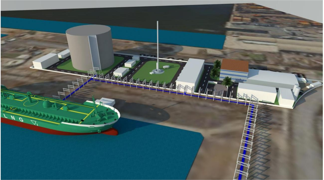
Figura 47 - Render del layout impiantistico con serbatoio criogenico da 10.000 m3 di GNL - Serbatoio e opere accessorie
