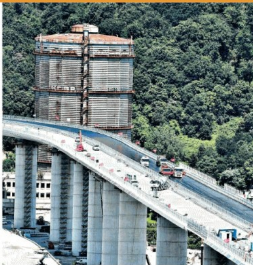
▲ L'ex Morandi Lavori di asfaltatura sul nuovo Ponte di Genova
