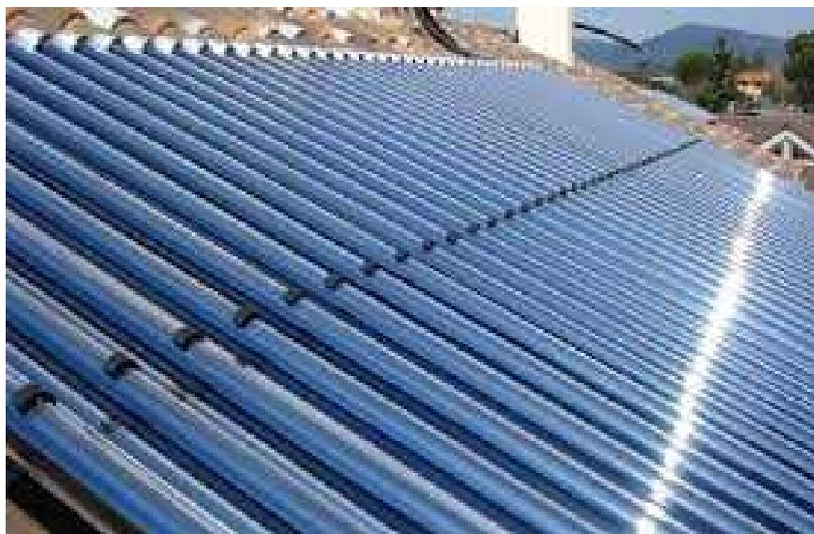
Figura 42. Esempio di installazione solare termica a tubi sotto vuoto
