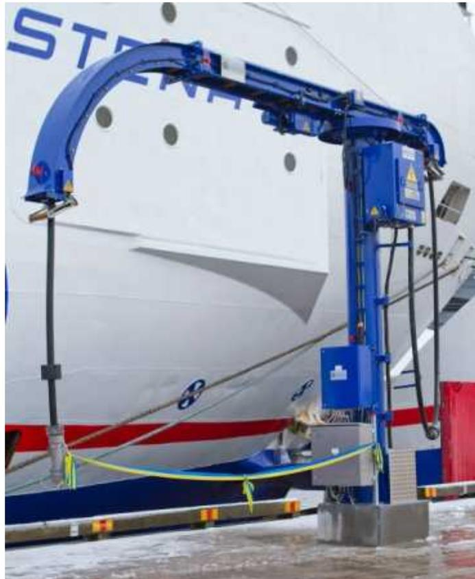
Figura 21. Avvolgicavo fisso a colonna (fonte Cavotec).
