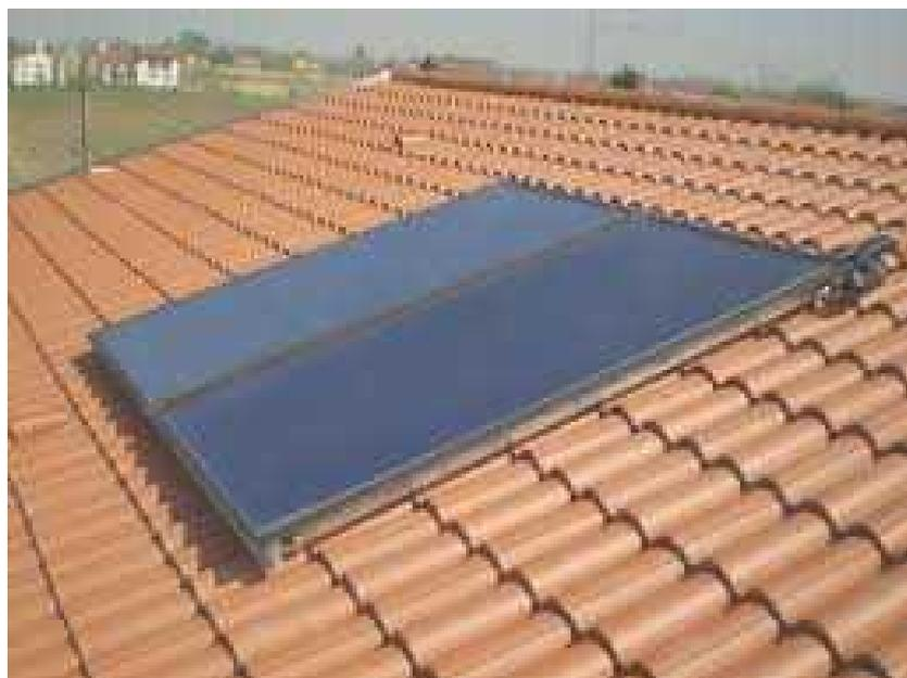
Figura 43. Esempio di installazione solare termica a pannelli vetrati
