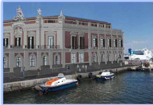
Cantiere di restauro Immacolatella vecchia
