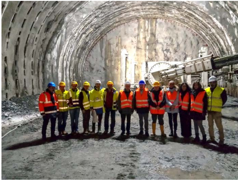
Ripresa dei Lavori di Scavo – 07/01/2019
