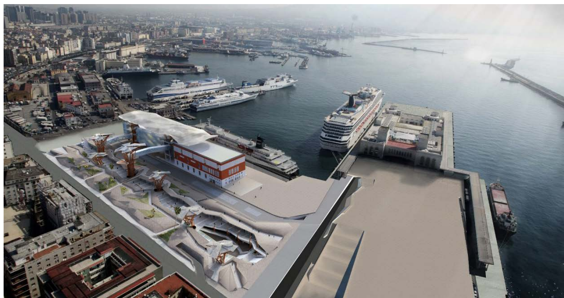
Recupero dell'edificio ex Magazzini generali
