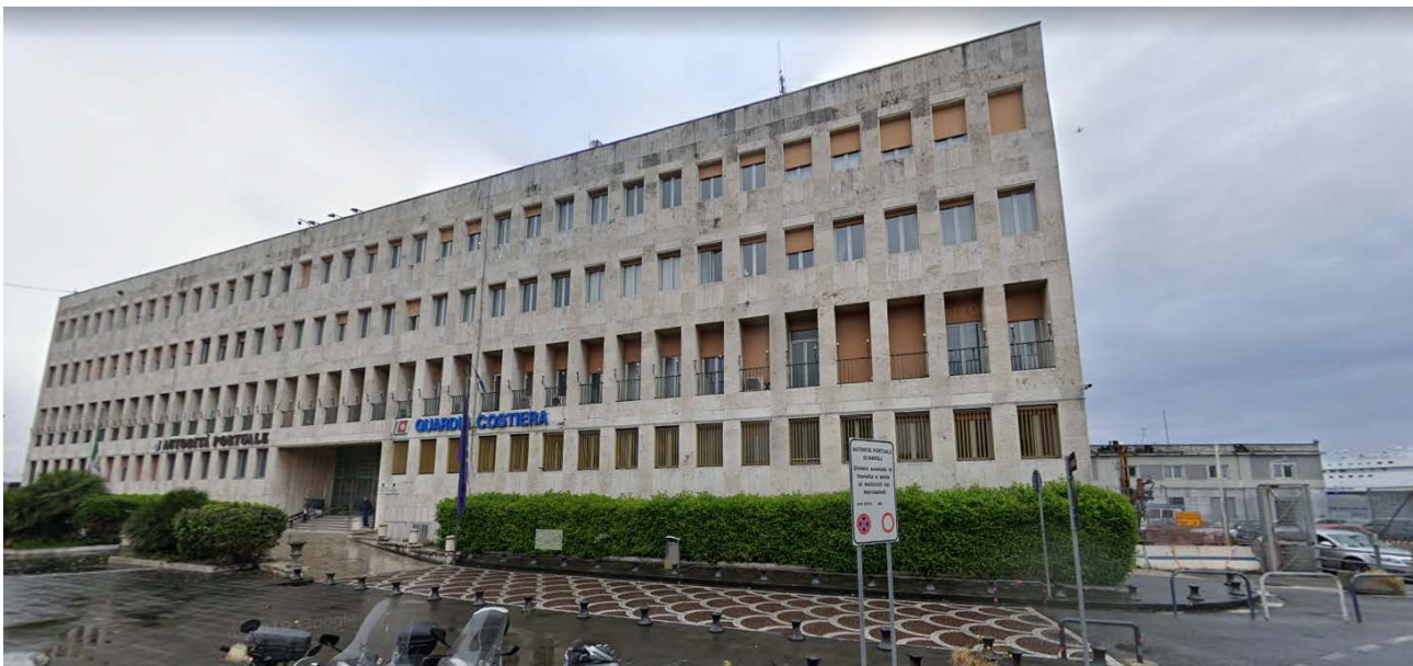
Figura 2. Vista frontale dell'edificio
