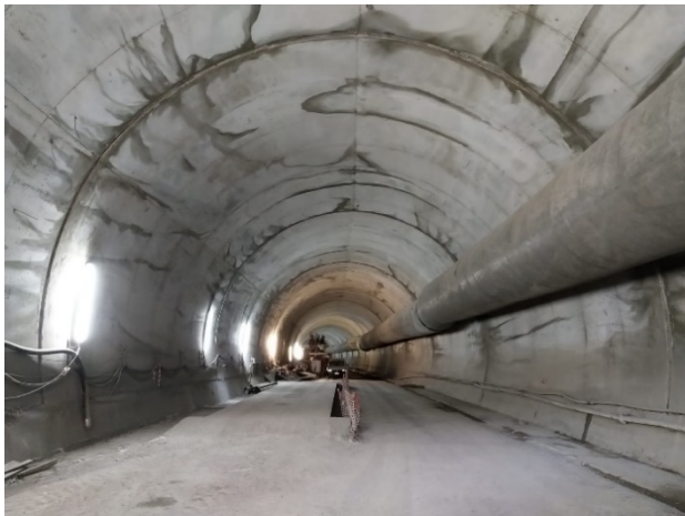
- Fronte già realizzato -
