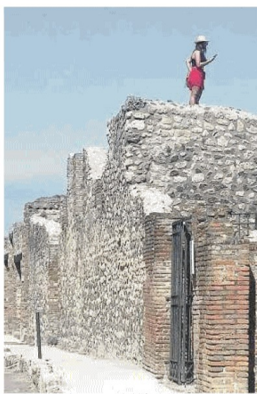
La turista sul tetto di una domus tra inciviltà e rischi per la propria incolumità
