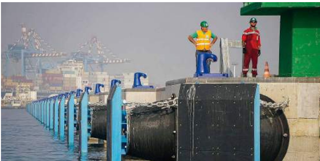
Lavori in banchina nel porto di Napoli
