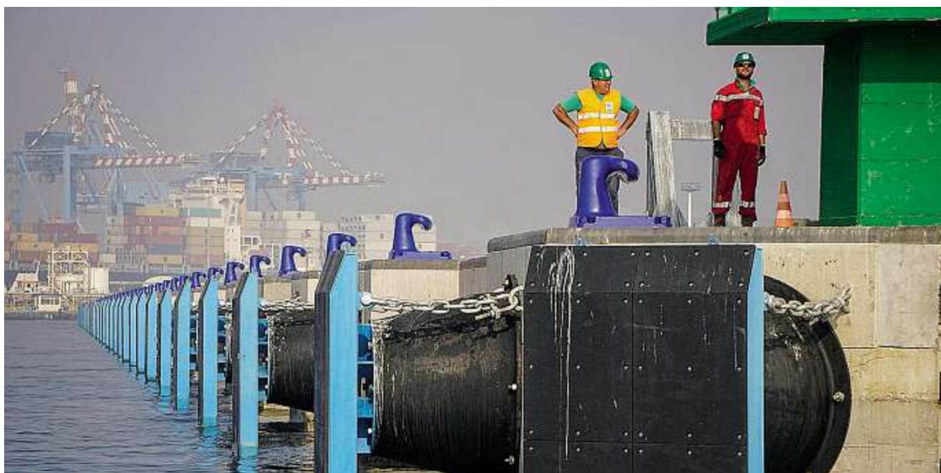
Lavori in banchina nel porto di Napoli
