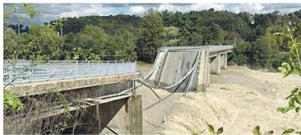
Il ponte sul fiume Sesia crollato a Romagnolo, in provincia di Novara: chiuso nella notte era stato riaperto da poco
