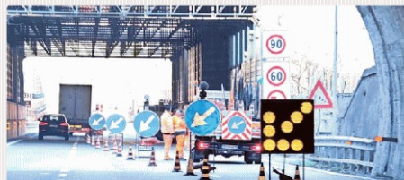
Un cantiere autostradale sulla A10
