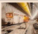
Il cantiere di ferma
