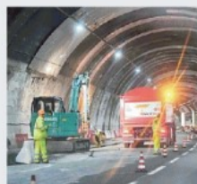
Un cantiere in galleria sulla A26
