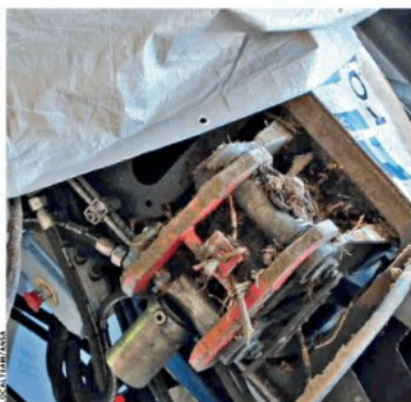
▲ Il forchettone il dispositivo che avrebbe disattivato il freno di sicurezza della cabina
