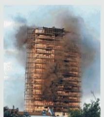
Il grattacielo distrutto -P.15
