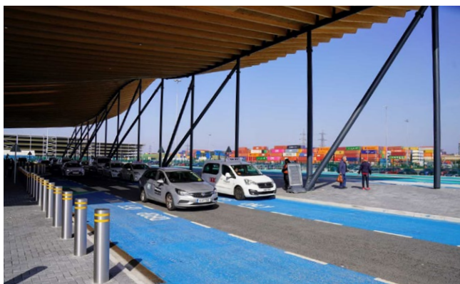
Area di sosta coperta all'Horizon Terminal di Southampton.
