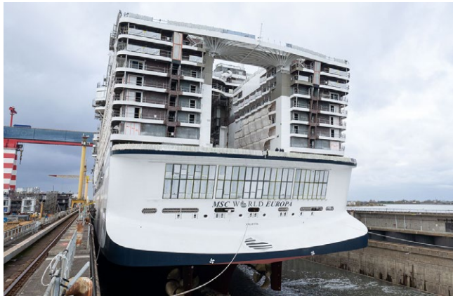
MSC World Europa in costruzione, vista di poppa.
