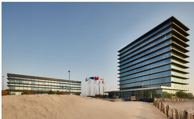
CSMART, vista esterna della sede ad Almere.
