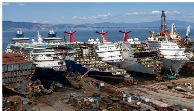
Navi Carnival ed ex RC in demolizione ad Aliaga, Turchia, 2020.
